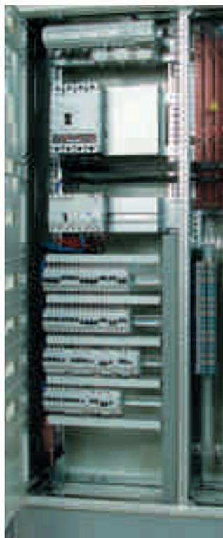
▲ Sistema barre 250-400 A orizzontale/verticale installato in verticale nel vano L170 mm delle strutture L885, P260 e P400
