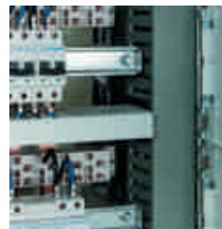
▲ Fissaggio delle canaline orizzontali e verticali con supporto ad innesto
